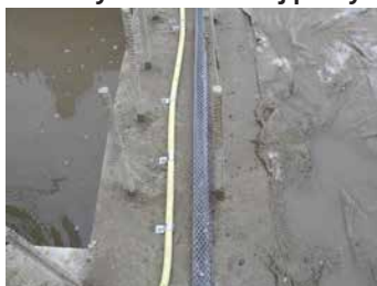
Kombinácia injektážnej hadičky a bentonitovej pásky.
